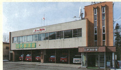
現在の二戸消防本部の庁舎
